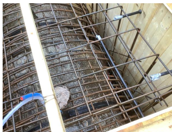
Bilde viser reparasjon med betong ved en skjøt.
